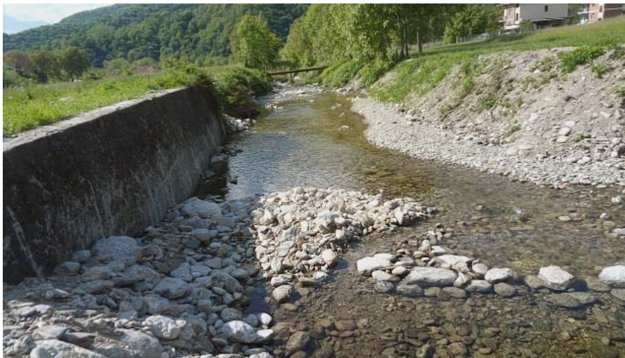
Figura 4: alveo del canale scolmatore nel tratto di intervento.
