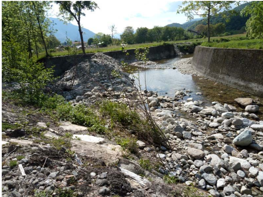
Figura 9: sbarramento in materiale sciolto provvisorio realizzato a seguito degli eventi alluvionali del novembre 2016.
